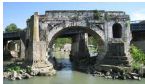
Figura 143. Arcata del Ponte Rotto
