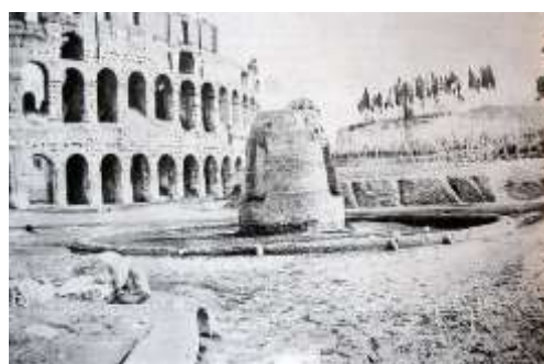
Figura 133. Resti della Meta Sudans prima della demolizione
