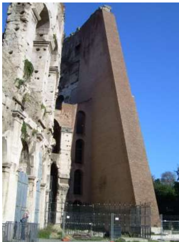
Figura 74. Contrafforti di consolidamento Colosseo
